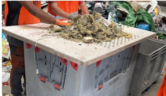
Criblage des <100mm sur la maille de 20mm
